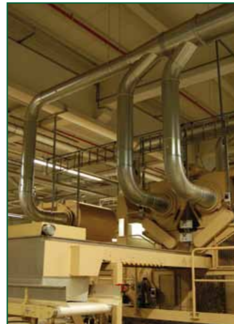
Afvoer van separatielucht bij het scheiden van de lichte en zware delen van de tabak
