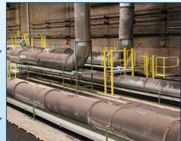
Afvoerkanaalen van de Elektrolytisch-Vertinlijn EV12 en -13 komen samen in een horizontaal kanaal richting natwasser. Schone lucht afkomstig uit de natwasserinstallatie gaat naar buiten. Uit emissiemetingen bleek inmiddels een uitstoot van minder dan 2 mg per normaal kub, voor de totale stofverontreiniging. Dat is onder de norm van de Nederlandse Emissie Richtlijnen (NER)
