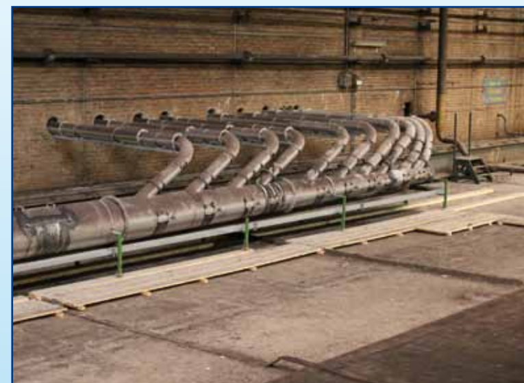
Afvoerkanaalen van de Elektrolytisch-Vertinlijn EV12 en -13 komen samen in een horizontaal kanaal richting natwasser. Schone lucht afkomstig uit de natwasserinstallatie gaat naar buiten. Uit emissiemetingen bleek inmiddels een uitstoot van minder dan 2 mg per normaal kub, voor de totale stofverontreiniging. Dat is onder de norm van de Nederlandse Emissie Richtlijnen (NER)
